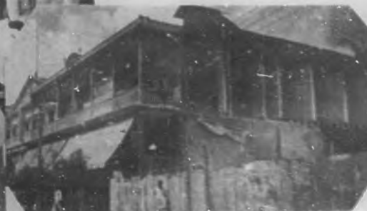
GUANTANAMO.—El edificio del hotel "Washington", que sufrió daños en el reciente incendio. El ingeniero municipal pide que sea demolido este edificio
